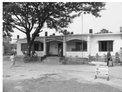
パイクパラセンターとして使っている自治会室の建物
